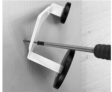
4. Am Ende zieht sich der Haken an die Wand und der Schraubendreher greift schräg in den TX-Antrieb.
